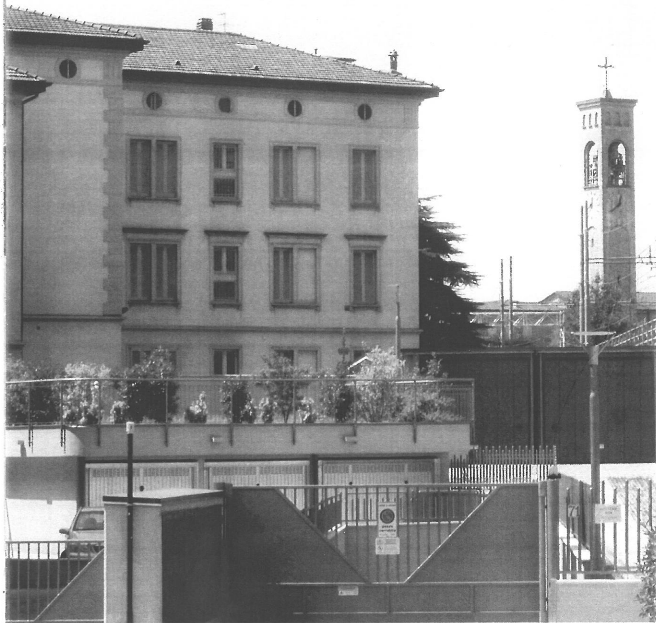
UNA VEDUTA LATERALE DELLA SEDE DI VILLA QUARTI CHE OSPITA RIFUGIATI DI GUERRA O CHIEDENTI ASILO. A SINISTRA UN MOMENTO DELL'OPEN DAY CHE HA PERMESSO AGLI ABITANTI DEL QUARTIERE DI CONOSCERE DA VICINO LA STRUTTURA E LE FINALITÀ DEL PROGETTO DI ACCOGLIENZA
