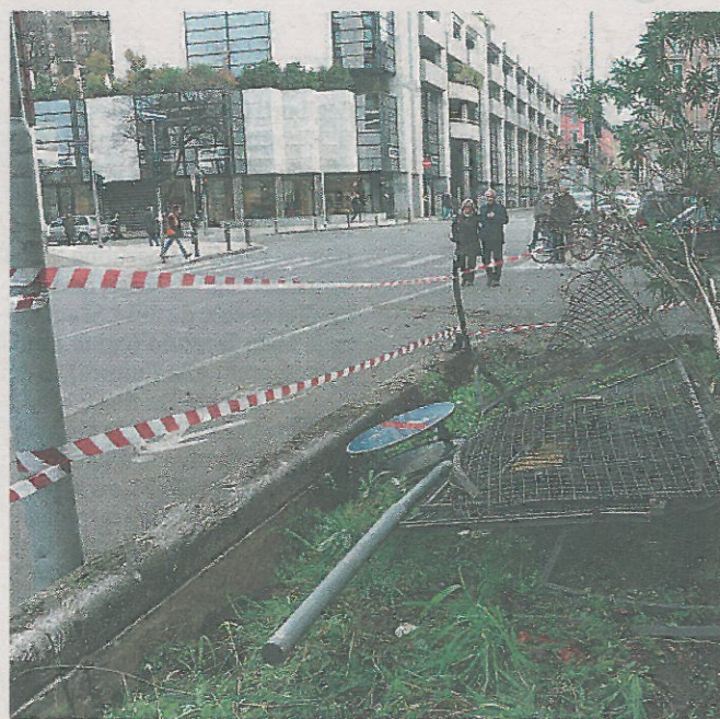
Distrutti La recinzione di una casa e un palo abbattuti
